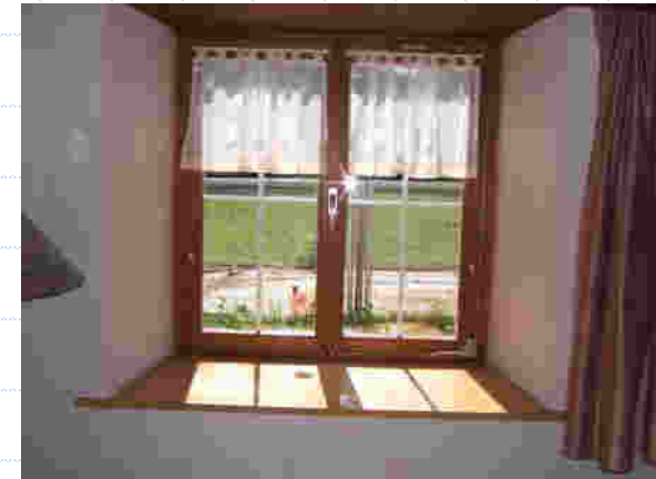
... ergibt eine tiefe Fensternische
