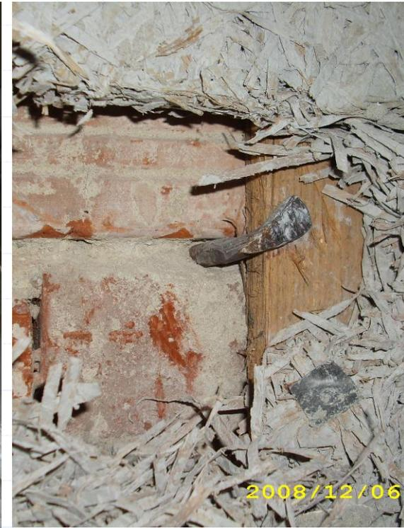
Ursache: Innendämmung - Kondensatausfall innerhalb der Mauer.
