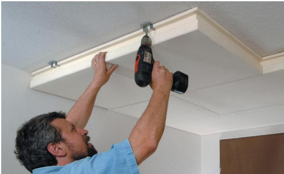
Die Kellerdecke kann in Eigenleistung gedämmt werden. Es empfiehlt sich, wegen des besseren  $\lambda$  - Wertes PU-Schaum zu verwenden, insbesondere, wenn die Kellerhöhe eingeschränkt ist.
