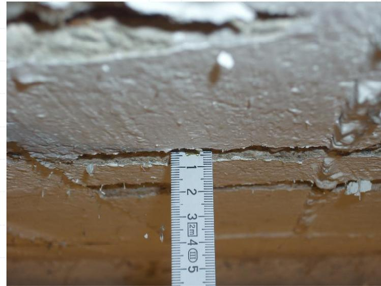
Kellerdeckenarmierung durch andauernde Feuchtebelastung und mangelnde Betonüberdeckung korrodiert. Folge: abgesprengter Beton.
