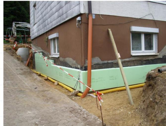
Im Zuge der Trockenlegung des Gebäudes kann die Dämmung bis auf die Kellersohle verlegt werden.
