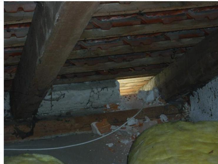
Die Schnittstelle Sparren/Außenwand ist sowohl von Dämmung als auch von der Winddichtung problematisch. Hier muss besonders sorgfältig gearbeitet werden.
