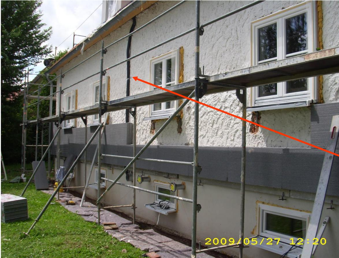
Vor Anbringen des Vollwärmeschutzes empfiehlt es sich, Versorgungsleitungen, etwa für Antenne oder Solaranlage auf der Wand zu verlegen.
