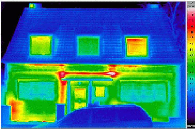
Mangelhaft gedämmte Heizleitungen und Heizkörpernischen sind nach Anbringen der Fassadendämmung kein Problem mehr.
