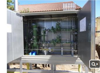
Eine zweischienige Gas-Druckregel- und Messanlage (GDRM-Anlage) im Aluminiumschrank
